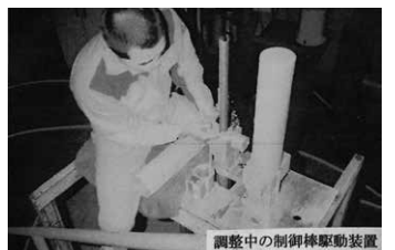
調整中の制御棒駆動装置
