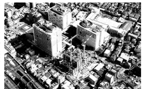
建設中の新校舎(平成28年2月26日撮影)
